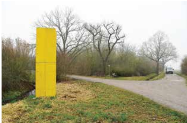
MARKUNG_EU TRANSform Stadtbesetzung Euskirchen, Trafohaus Satzvey H: 4,00 m B: 1,02 m T: 1,02 m, Material: Schaltafeln gelb, Kanthölzer, Schrauben, Markierungsfarbe, Foto: Clemens Botho Goldbach
